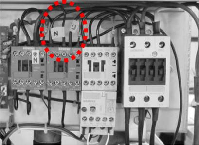
1° Desligar a extremidade identificada dos jumpers L3 e N.
